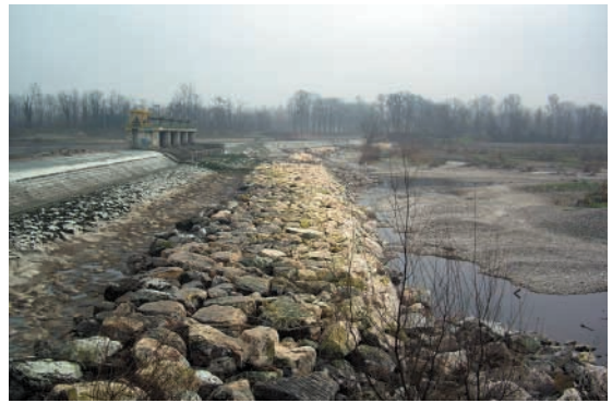
Fig. 4. Fiume Adda. Sbarramento all'altezza del canale Vacchelli. L'interruzione della continuità fluviale e la mancanza del minimo deflusso vitale sono tra le principali cause della rarefazione di molte specie di pesci (foto Andrea Agapito Ludovici).
